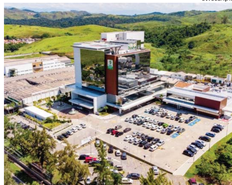
HOSPITAL da cooperativa Unimed em Volta Redonda
